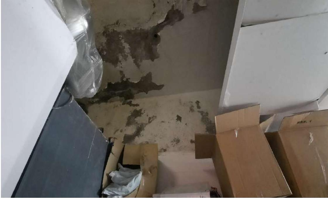
*4-Existen filtraciones en varias paredes de cerramiento del mercado y en paredes medianeras con edificaciones colindantes.*
