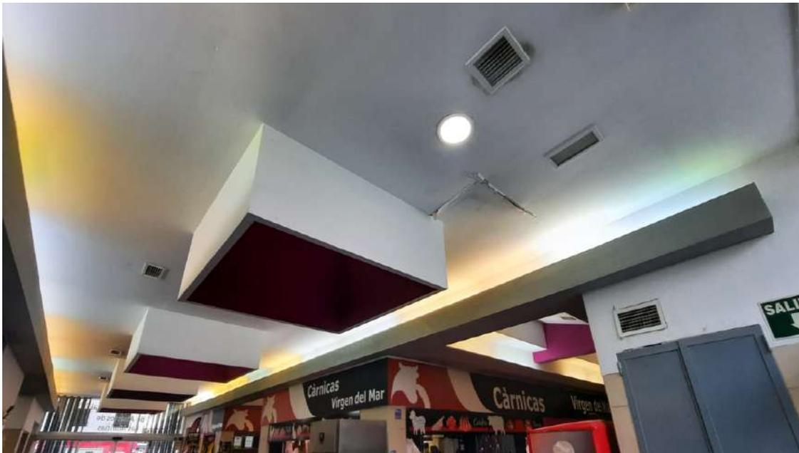
*2-Existe otra filtración de agua procedente de la cubierta que deja inundado el lucernario de iluminación indirecta en el pasillo de comunicación interior del mercado.*
