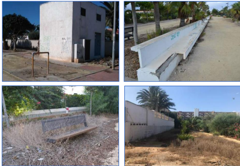
Estado actual de los espacios intermedios
