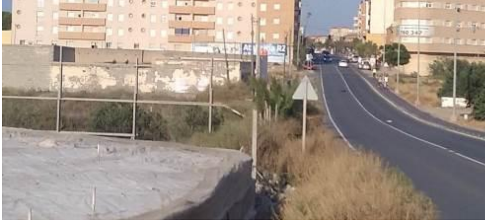
Valla, terraplén, arcén y calzada. Fotografía tomada el 20 de julio de 2022.
